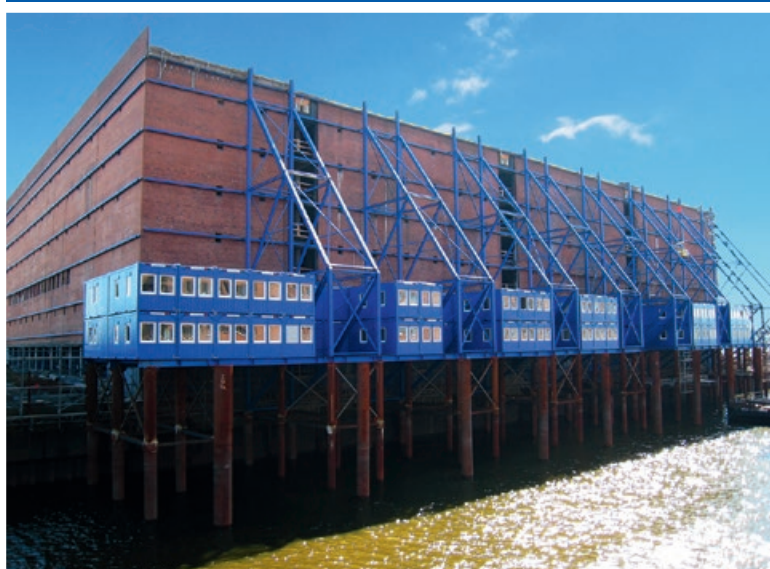
Строительный офис на площадке в особых условиях
