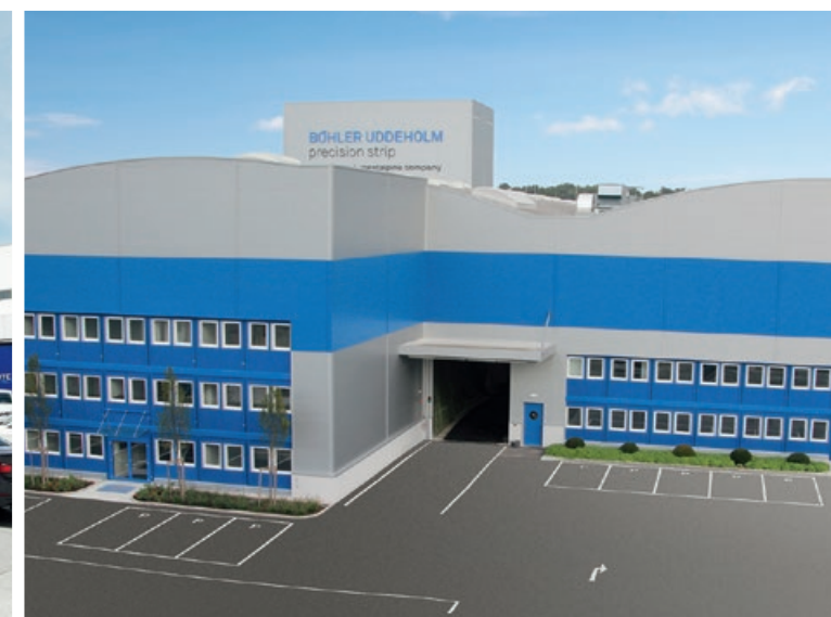
Офис на производстве
